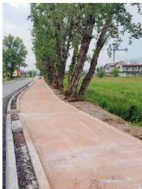
Pista. Il tratto appena ultimato
